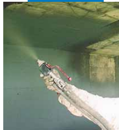
Нанесение Mapelastic на виадук распылением
