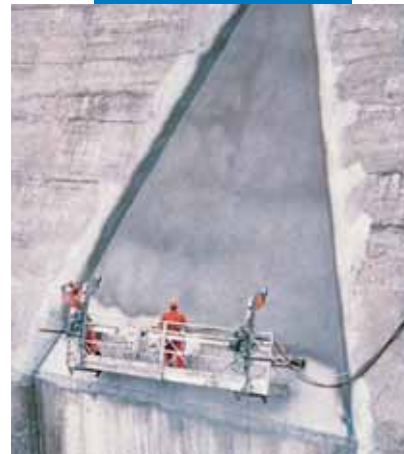
Нанесение Mapelastic на дамбу распылением
