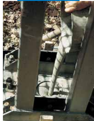
Анкерное крепление с помощью раствора Mapesfill
