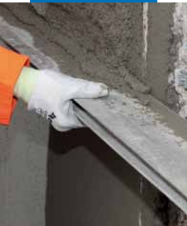
Выравнивание MapegROUT 430 при помощи правила
