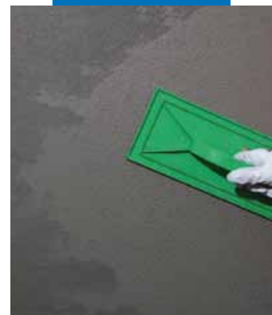
Трамбовка MapregROUT 430
