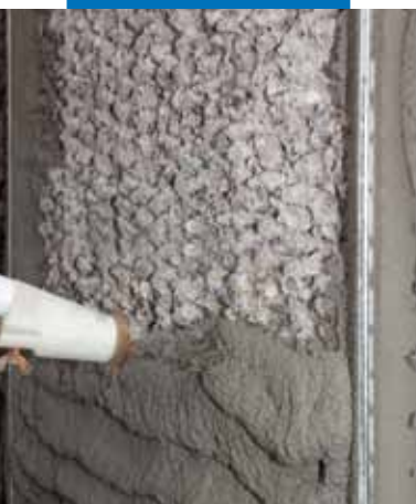
Нанесение MapegROUT 430 набрызгом
